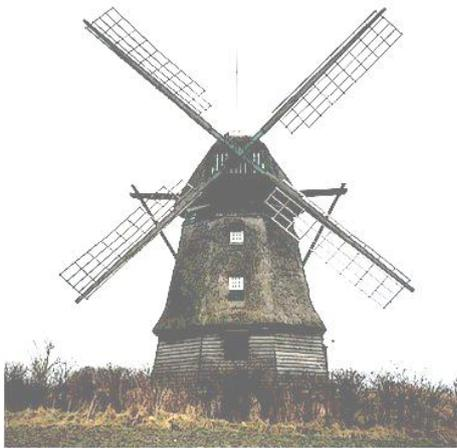
Die **Windmühle Farve** wurde 1828 erbaut. Sie ist ein Erdholländer mit Segelflügeln und Steert, die nicht windgängig sind. Die Einrichtung ist teilweise vorhanden. Da die Mühle privat bewohnt wird, ist eine Besichtigung nur von außen möglich.
