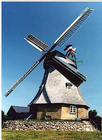
Die **Windmühle Auguste** wurde 1874 erbaut. Sie ist ein Kellerholländer mit Windrose und Jalousieflügeln. Die Windmühle wurde 1998 bis 2001 umfassend restauriert. Sie ist windgängig und mahlfähig.
