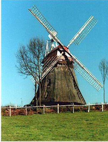
Die **Windmühle Wagria** wurde 1851 erbaut. Sie ist ein Kellerholländer mit Windrose und Segelflügeln. Sie ist nicht windgängig. Im Inneren der Mühle befinden sich eine Töpferausstellung sowie ein Dorfmuseum im Aufbau.
