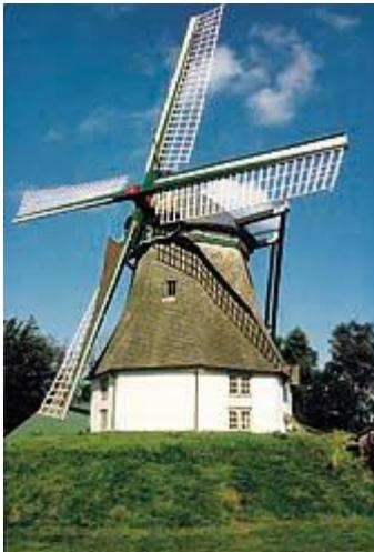
Die **Mühle Hoffnung** wurde 1845 in Meierwik (zwischen Flensburg und Glücksburg) gebaut und 1868 nach **Munkbrarup** versetzt. Sie besitzt noch den alten Steert zum „Kroien“ der Kappe in den Wind. Auch im Inneren ist die alte Einrichtung mit zwei Schrotgängen, einem „Franzosen“ und einem kompletten Schälengang erhalten. Ein interessantes technisches Denkmal. In der Nähe befindet sich in einem schmucken Fachwerkhaus ein Backofen, in dem noch gebacken wird.
