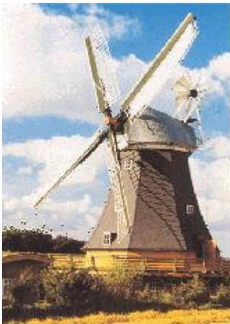
Die **Windmühle Sventana in Ascheberg** wurde 1860/1890 als einstöckiger Galerieholländer mit Windrose und Jalousieflügeln erbaut. Sie ist windgängig, mahlfähig und eine der am häufigsten drehenden Windmühlen des Landes. (ca. 300.000 Flügelumdrehungen im Jahr).
