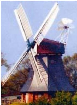
Die **Windmühle Krokau** wurde 1872 erbaut. Sie ist ein Kellerholländer mit Windrose und Jalousieflügeln. Die komplette Einrichtung ist erhalten, sie ist windgängig und mahlfähig. Es kann der Mahlvorgang und die Zubereitung von Mühlenbrot beobachtet werden.
